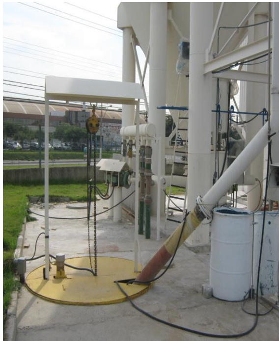
Figura 2.4 - Reservatório onde a água proveniente do processo de lapidação é armazenada antes do tratamento
