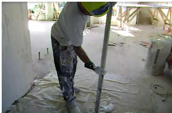
Figura 4.1(a) – Coleta do resíduo de gesso.
