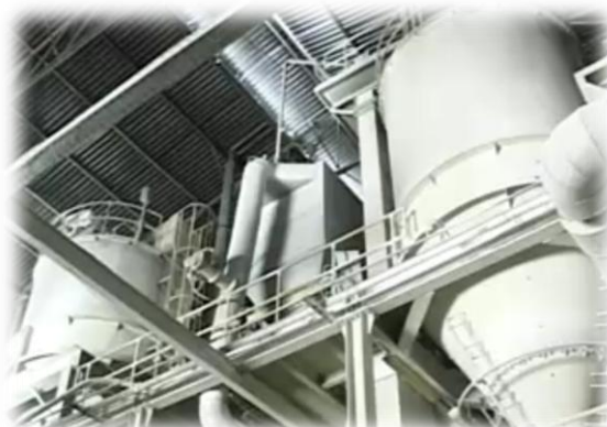
Figura 3.10 – Silos de estabilização.
