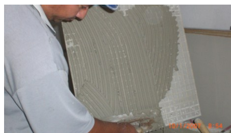
Figura 4.54 – Argamassa aplicada sobre a placa com o lado denteado da desempenadeira.
