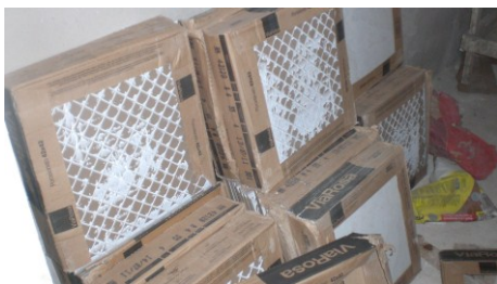
Figura 4.117 – Caixas de porcelanato armazenadas próximas ao local de aplicação na obra 04. Figura 4.118 – Placas fixadas na parede para indicar o local de aplicação na obra 04.
