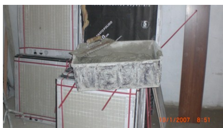
Figura 4.47 – Caixa de argamassa apoiado sobre as caixas do porcelanato na obra 01.
