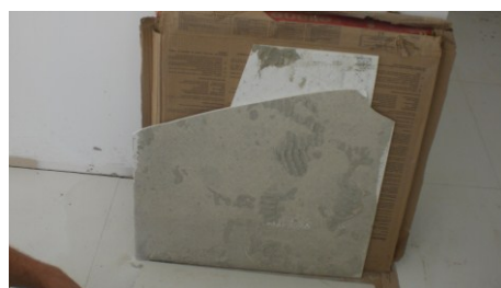
Figura 4.92 – Placas arrancadas para verificar o preenchimento da argamassa
