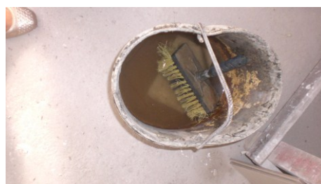
Figura 4.96 – Utensílio utilizado no umedecimento da base
