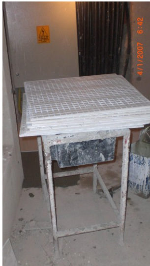
Figura 4.81 – Bancada com placas de porcelanato apoiadas
