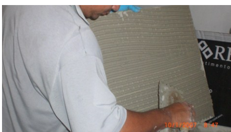
Figura 4.55 – Argamassa aplicada sobre a placa
