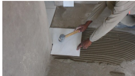
Figura 4.132 – Uso do martelo de borracha para assentamento da placa.
