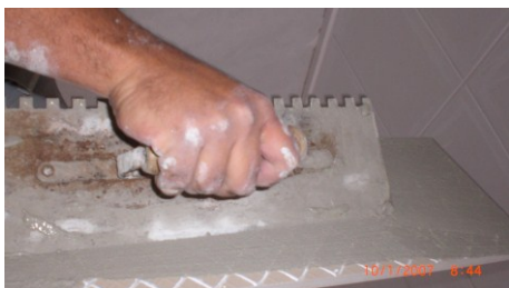
Figura 4.63 – Detalhe da aplicação da argamassa colante com o lado liso da desempenadeira denteada
