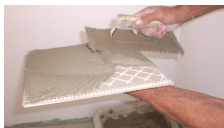
Figura 4.100 – Aplicação da argamassa com desempenadeira denteada de 8mm
