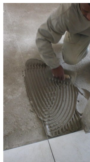
Figura 4.124 – Argamassa colante penteada com desempenadeira dentada.
