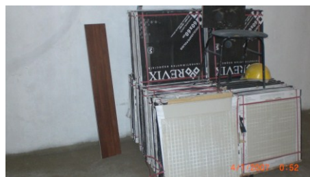
Figura 4.44 – Caixas de porcelanato com objeto apoiado (cadeira) sobre as pilhas.
