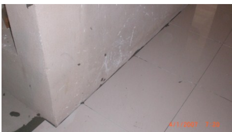
Figura 4.87 – Porcelanato aplicado na obra 02.
