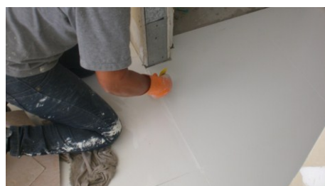
Figura 4.108 – Rejunte epóxi sendo utilizado
