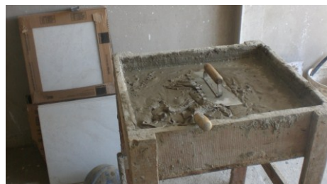
Figura 4.136 – Argamassa e placas de porcelanato utilizadas.
