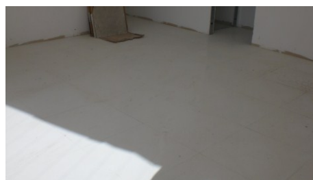
Figura 4.112 – Porcelanato assentado em um dos apartamentos da obra 03.
