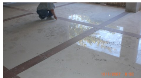
Figura 4.66 – Limpeza das juntas de assentamento para rejuntamento.
