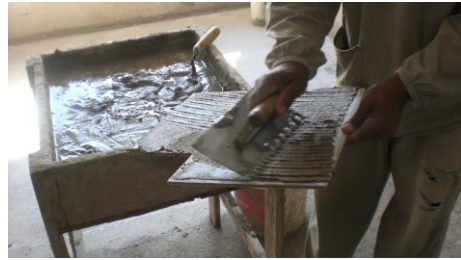
Figura 4.130 – Desempenadeira denteada espalhando argamassa sobre a placa.
