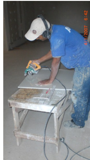
Figura 4.82 – Bancada de corte da obra 02.
