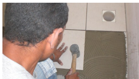
Figura 4.102 – Uso do martelo de borracha sobre a placa de porcelanato.
