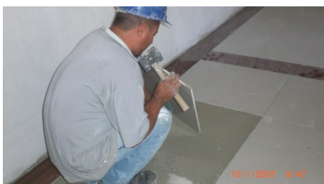
Figura 4.57 – Porcelanato sendo aplicado
