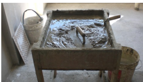
Figura 4.119 – Caixote de madeira sendo utilizado para preparar argamassa colante na obra 04. Figura 4.120 – Bancada de corte da obra 04.
