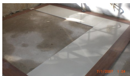
Figura 4.50 – Pré-paginação sobre o contrapiso com disposição das placas alinhadas.
