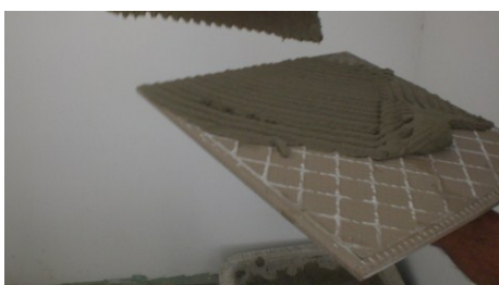
Figura 4.99 – Aplicação da argamassa colante sobre a placa na obra 03.
