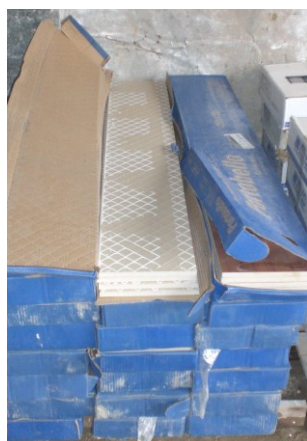
Figura 4.45 – Caixas de porcelanato estocadas na obra 01.
