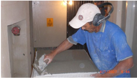
Figura 4.83 – Aplicação da argamassa com a desempenadeira denteada.
