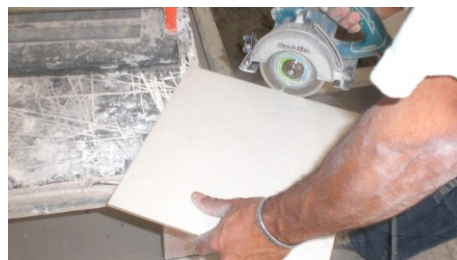
Figura 4.106 – Peça sendo cortada para arremate.
