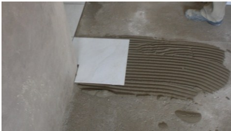
Figura 4.131 – Placa assentada
