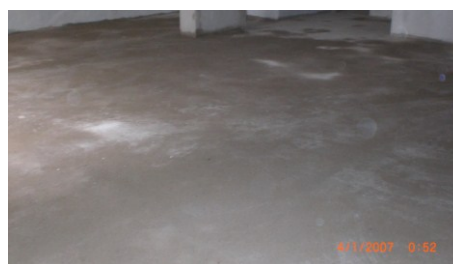
Figura 4.48 – Contrapiso pré-umedecido na obra 01.
