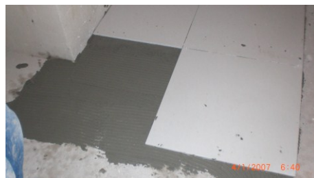
Figura 4.80 – Placa de porcelanato aplicada na obra 02.
