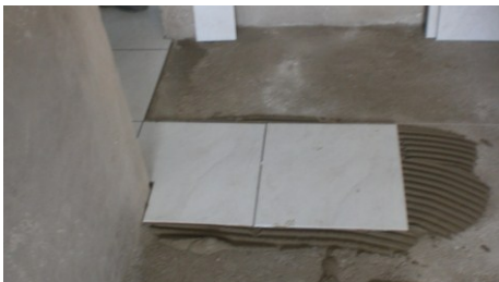
Figura 4.133 – Placas já assentadas
