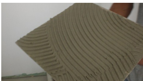
Figura 4.101 – Placa de porcelanato com argamassa aplicada
