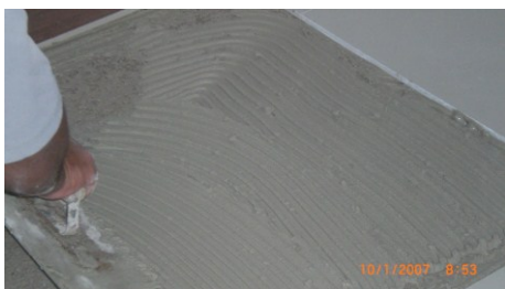
Figura 4.51 – Argamassa aplicada sobre a base na obra 01.
