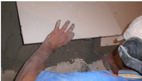
Figura 4.85 – Corerção da aplicação da argamassa utilizando a colher de pedreiro. Obra 02.
