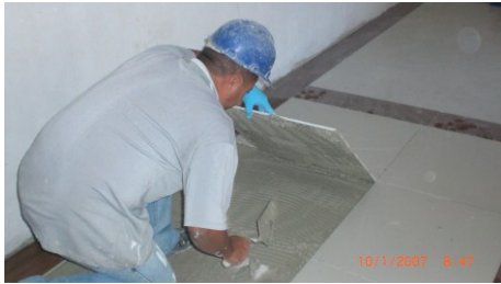
Figura 4.59 – Correção da aplicação da argamassa com colher de pedreiro
