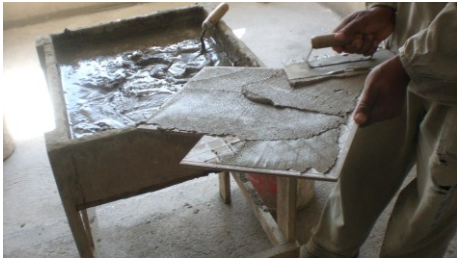
Figura 4.129 – Aplicação da argamassa sobre a placa de porcelanato na obra 04.
