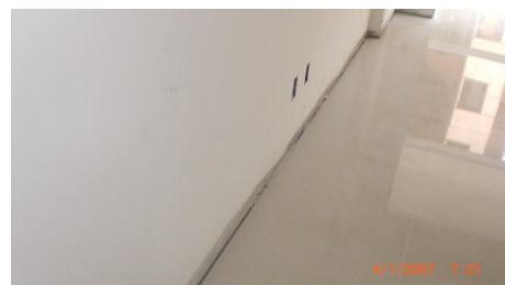
Figura 4.88 – Porcelanato polido já aplicado em um apartamento da obra 02.
