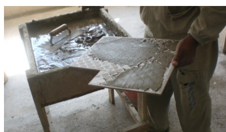
Figura 4.128 – Argamssa aplicada sobre a placa com o lado liso da desempenadeira
