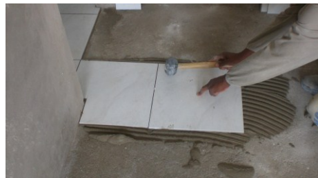
Figura 4.134 – Amassamento dos cordões de argamassa
