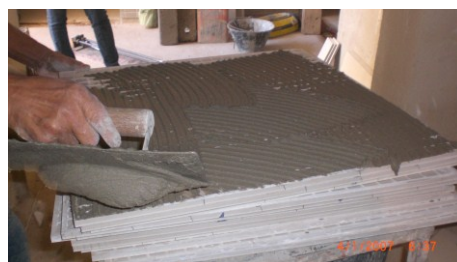
Figura 4.76 – Aplicação da argamassa na placa com a desempenadeira denteada.
