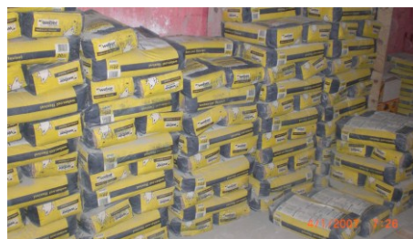
Figura 4.70 – Estoque de argamassa na obra 02.
