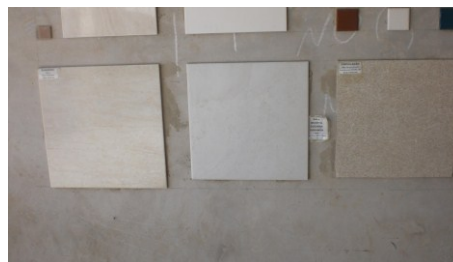
Figura 4.117 – Caixas de porcelanato armazenadas próximas ao local de aplicação na obra 04. Figura 4.118 – Placas fixadas na parede para indicar o local de aplicação na obra 04.
