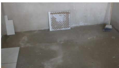
Figura 4.121 – Contrapiso pré umedecido n obra 04.
