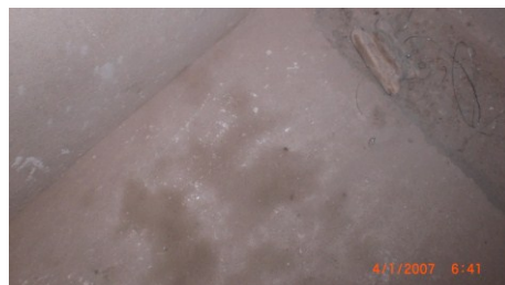
Figura 4.74 – Contrapiso pré-umedecido na obra 02.
