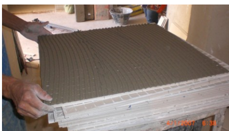
Figura 4.77 – Placa com argamassa aplicada
