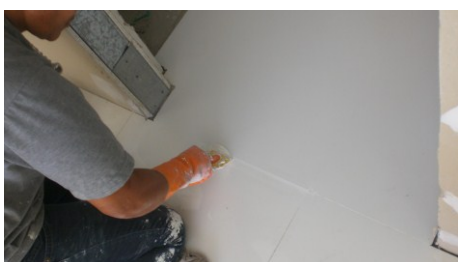
Figura 4.107 – Rejuntamento epóxi.
