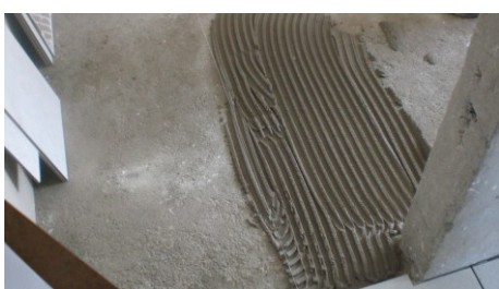
Figura 4.127 – Argamassa aplicada sobre o contrapiso aguardando o porcelanato
