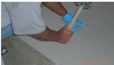
Figura 4.61 – Batidas sobre a placa com o martelo de borracha
