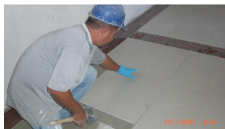
Figura 4.58 – Cordões de argamassa sendo amassados
