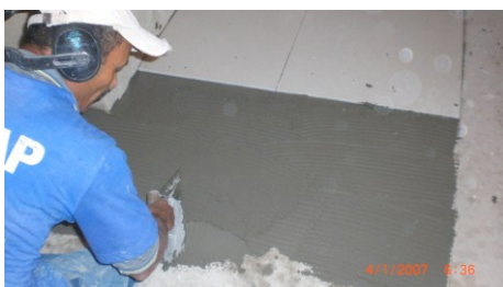
Figura 4.75 – Aplicação da argamassa no contrapiso da obra 02.
