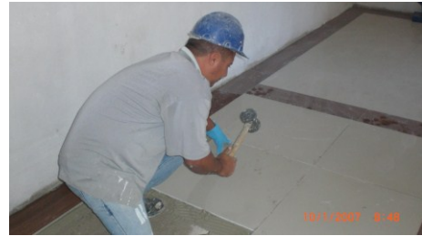
Figura 4.60 – Uso do martelo de borracha sobre a placa
