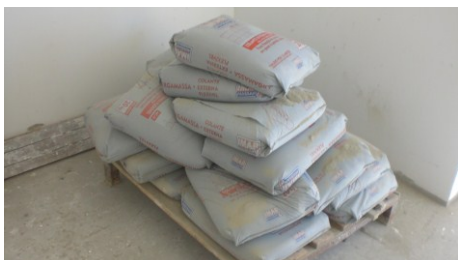
Figura 4.89 – Argamassa colante utilizada armazenada no local de aplicação do porcelanato
