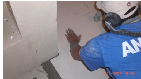
Figura 4.86 – Amassamento dos cordões de argamassa
