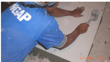
Figura 4.79 – Uso do martelo de borracha na obra 02.
