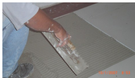
Figura 4.52 – Argamassa aplicada e penteada.
