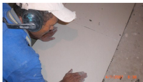
Figura 4.78 – Assentamento do porcelanato na obra 02.
