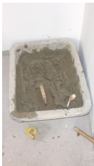
Figura 4.93 – Caixa de argamassa
