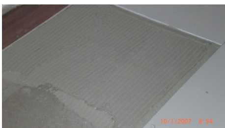
Figura 4.53 – Argamassa já aplicada sobre o contrapiso.
