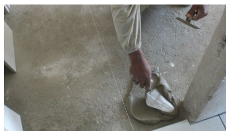
Figura 4.122 – Argamassa espalhada sobre o contrapiso com colher de pedreiro
