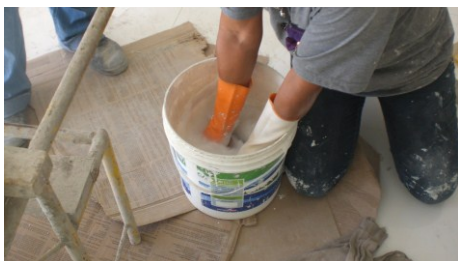
Figura 4.109 – Etapa de rejuntamento
