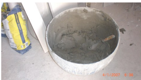
Figura 4.69 – Caixote de argamassa
