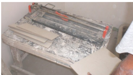
Figura 4.105 – Corte das peças sobre bancada na obra 03.
