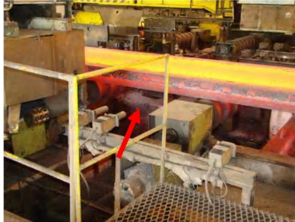
Figura 3.11. Base de concreto da mesa de rolos – indicação na seta em vermelho (detalhe da passagem de placa de aço)
