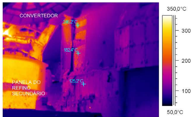
Figura 3.10. Termografia mostrando temperaturas entre 125,2°C e 246,2°C na lateral do pilar central do convertedor 2 da aciaria
