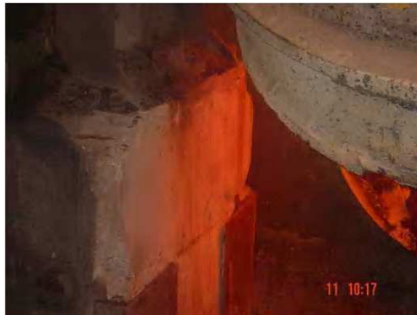
Figura 3.13. Base de concreto do virador de painéis
