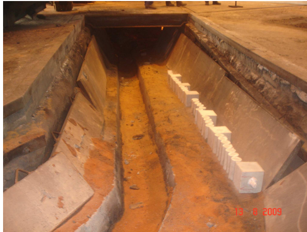
Figura 3.57. Corpos de prova posicionados internamente na lateral do início do canal secundário de escória 1 do alto forno 3
