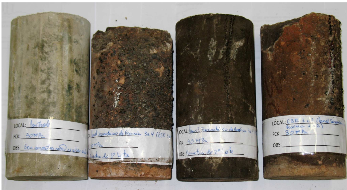
Figura 3.50. Aspecto geral dos corpos de prova de concreto C30. À esquerda a amostra de referência e à direita três amostras submetidas aos ciclos de radiação térmica
