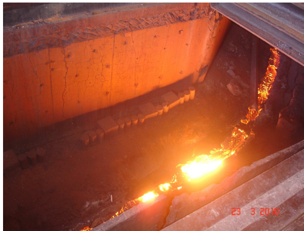
Figura 3.55. Canal secundário de escória 4 – altura maior no final do canal - Detalhe dos corpos de prova dispostos na lateral do canal.
