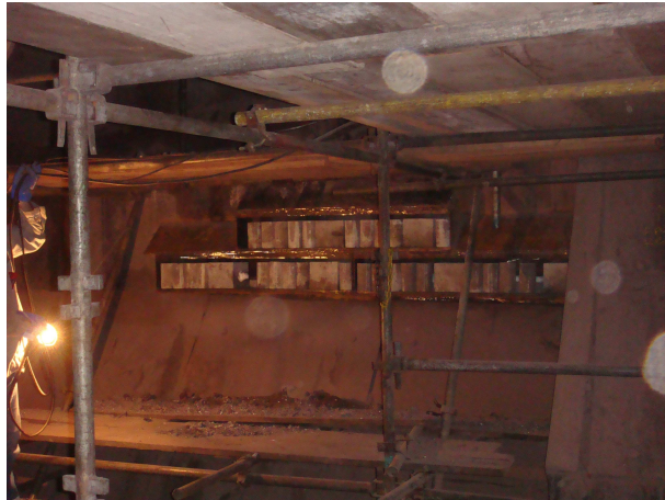
Figura 3.68. Corpos de prova posicionados na lateral do pilar central de sustentação do convertedor 2 na Aciaria
