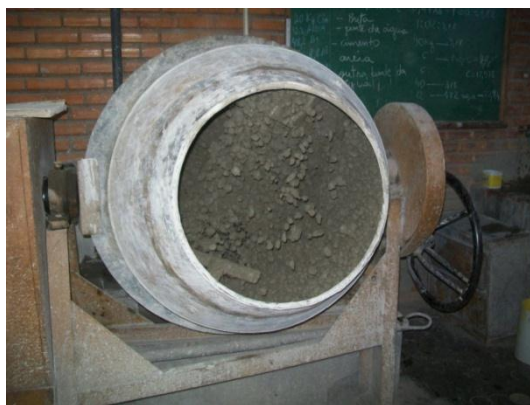
Figura 31 - Preparação do concreto na betoneira
