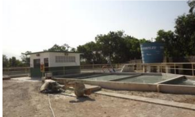
Figura 17 – Tanques de sedimentação em empresa capixaba beneficiadora de rochas ornamentais.
